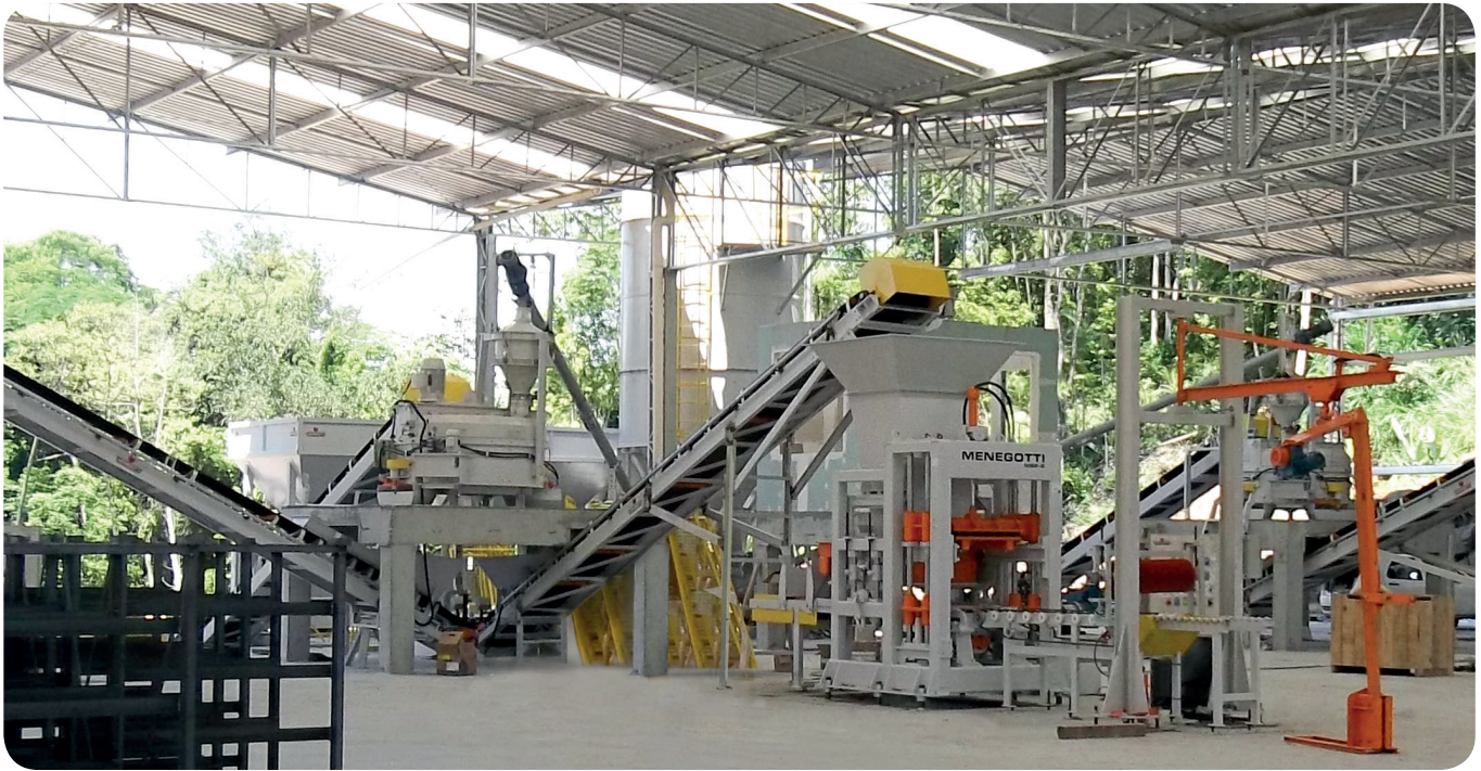
Central de Concreto para Produção de Artefatos e Pré-Moldados. | Batching Plant for Artifacts and Pre-Cast Parts. | Central en Hormigón para Artefactos y Pre-Moldeado.
